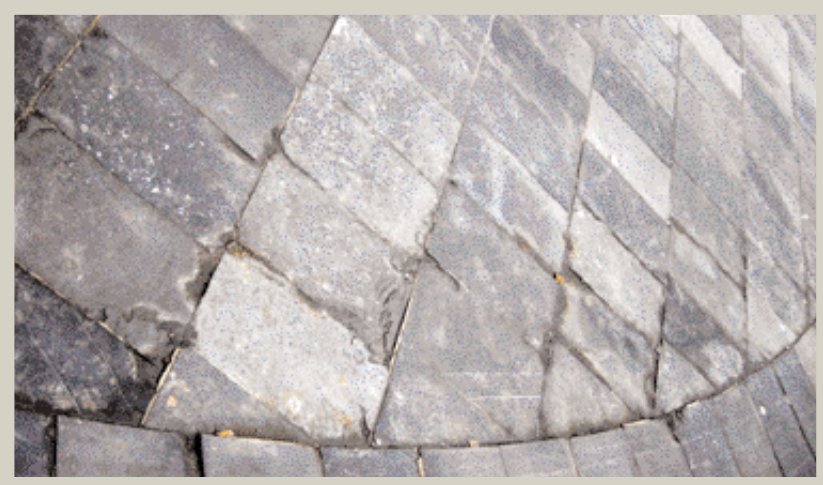
163 165 Caractéristiques techniques et différences de résistance. Ebréchures.
