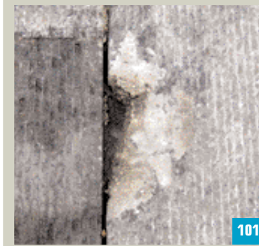
101 Ecaillage (15x20 cm) de noirures sur une grande dalle sclypée.
